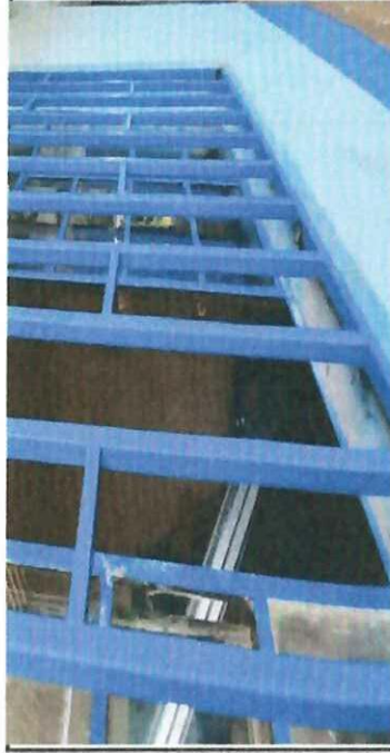
Foto 6: Cambio de 10 balcones.
