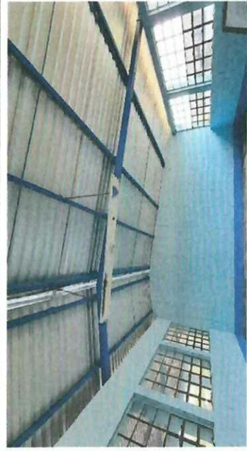
Foto1: Cambio completo del techo de la escuela.
